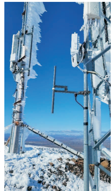
Ísing er viðvarandi á þessum árstíma þegar komið er upp í þetta mikla hæð. Nýuppsettur tvipóllinn sést á miðri mynd. Ljósmynd: TF3GZ.
